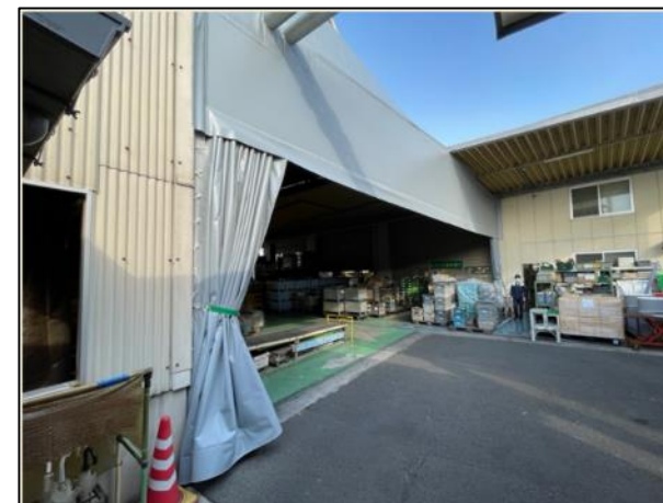
「防音シート」設置
