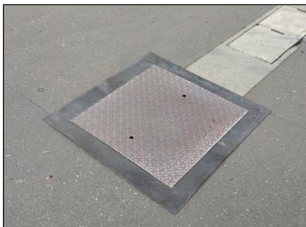
路面陥没箇所の鉄板敷設
